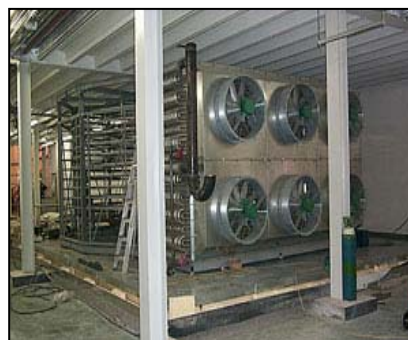
Déplacement d'un tambour hélicoïdal simple complètement rénové.
