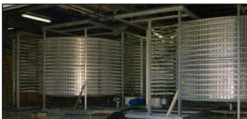
Installation eines Spiralfördersystems mit Doppeltrommel
