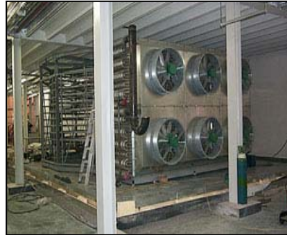
Verlegung einer Eintrommelspirale, vollständig renoviert.
